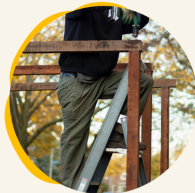
Bouw- en bodem- werkzaamheden
